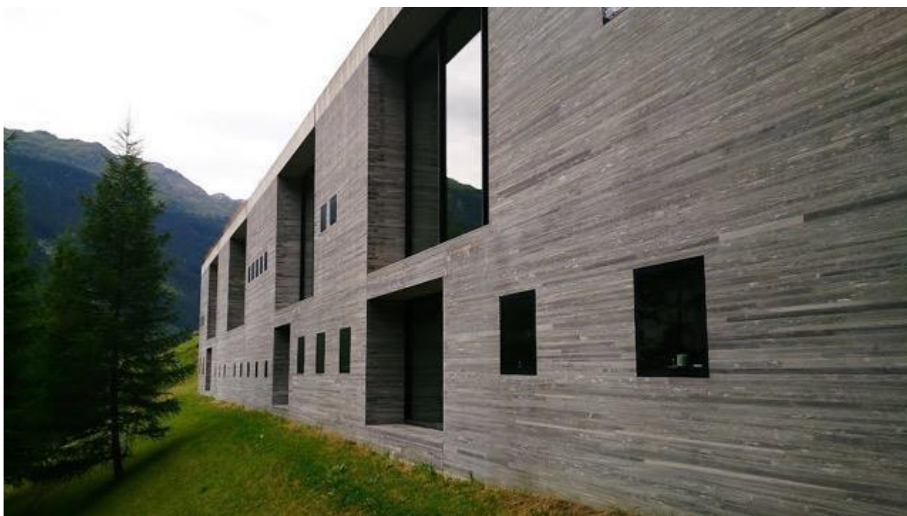
Thermen in Vaals (Zwitserland) - gebruik van harde materialen geeft toch een aantrekkelijk uiterlijk, pure materialen, minimale details, menselijke maat, rust.
